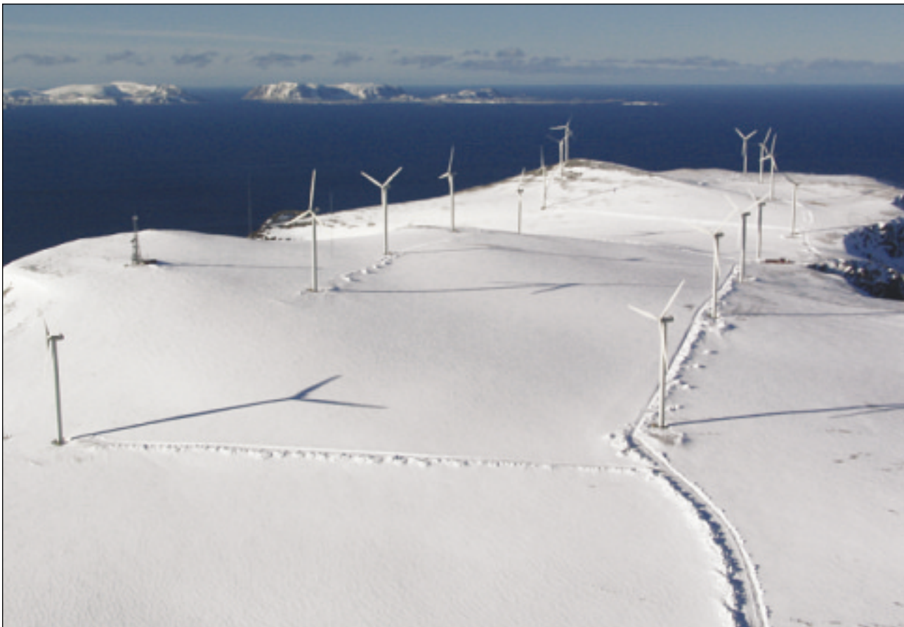
Figur 7: Illustrasjon av hvordan Havøygavlen vindkraftverk tar seg ut vinterstid. De 16 vindturbinene à 2,5 MW har 80 m tårnhøyde og 80 m rotordiameter.
