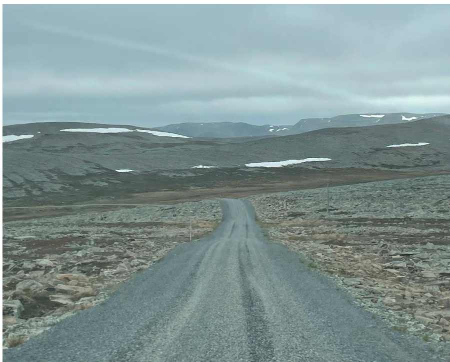
Figur 6. Viser deler av adkomstveien til Kjøllefjord vindpark, etter man har tatt av fra Fv894. Foto: Fred. Olsen Renewables
