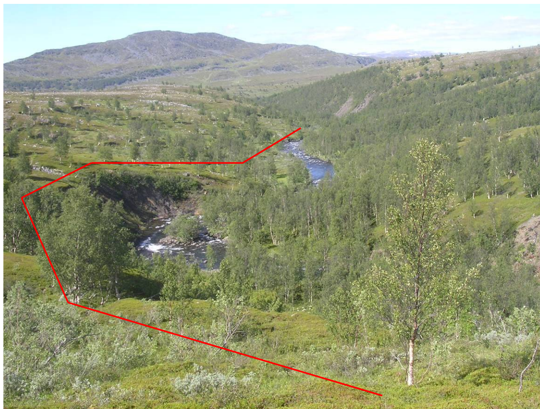
Aktuell vannvei sett fra kote 160-170 og ned mot kraftstasjon
