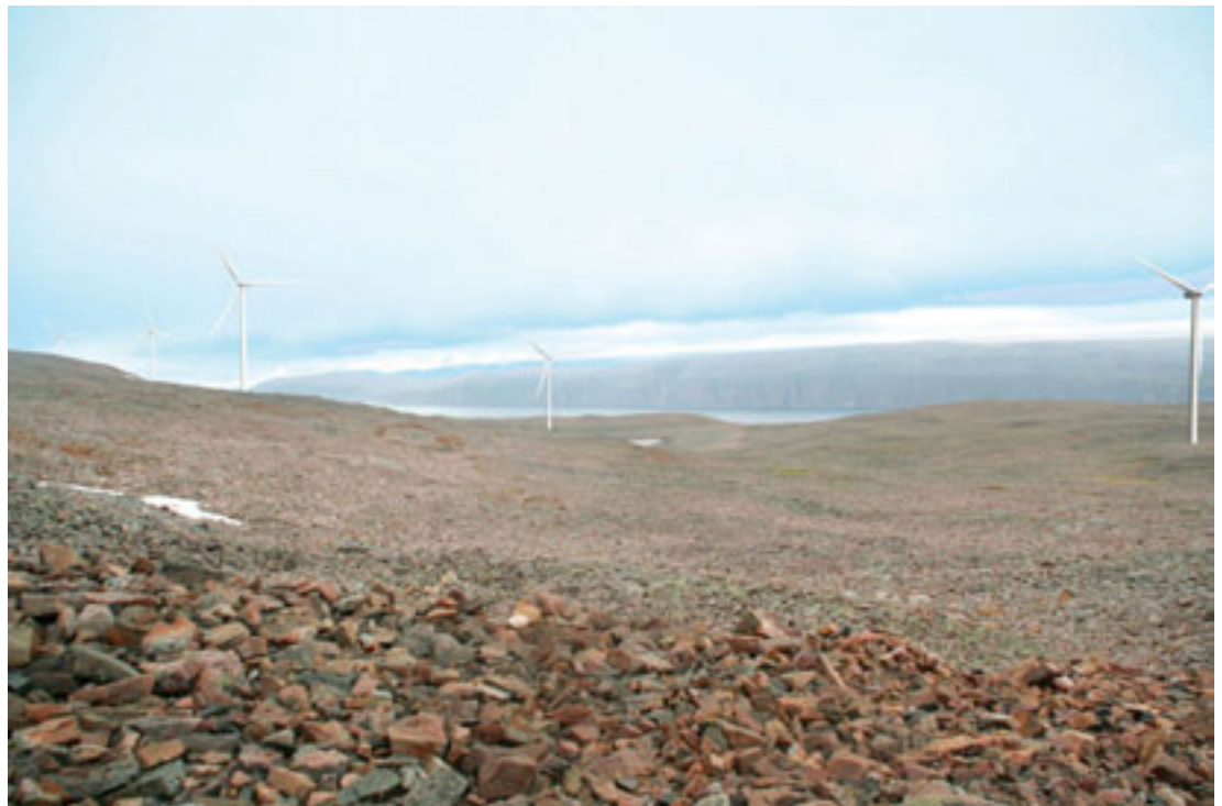
Fig. 8.2 Sør for Hamnefjell telemast, 3 MW-turbiner.
