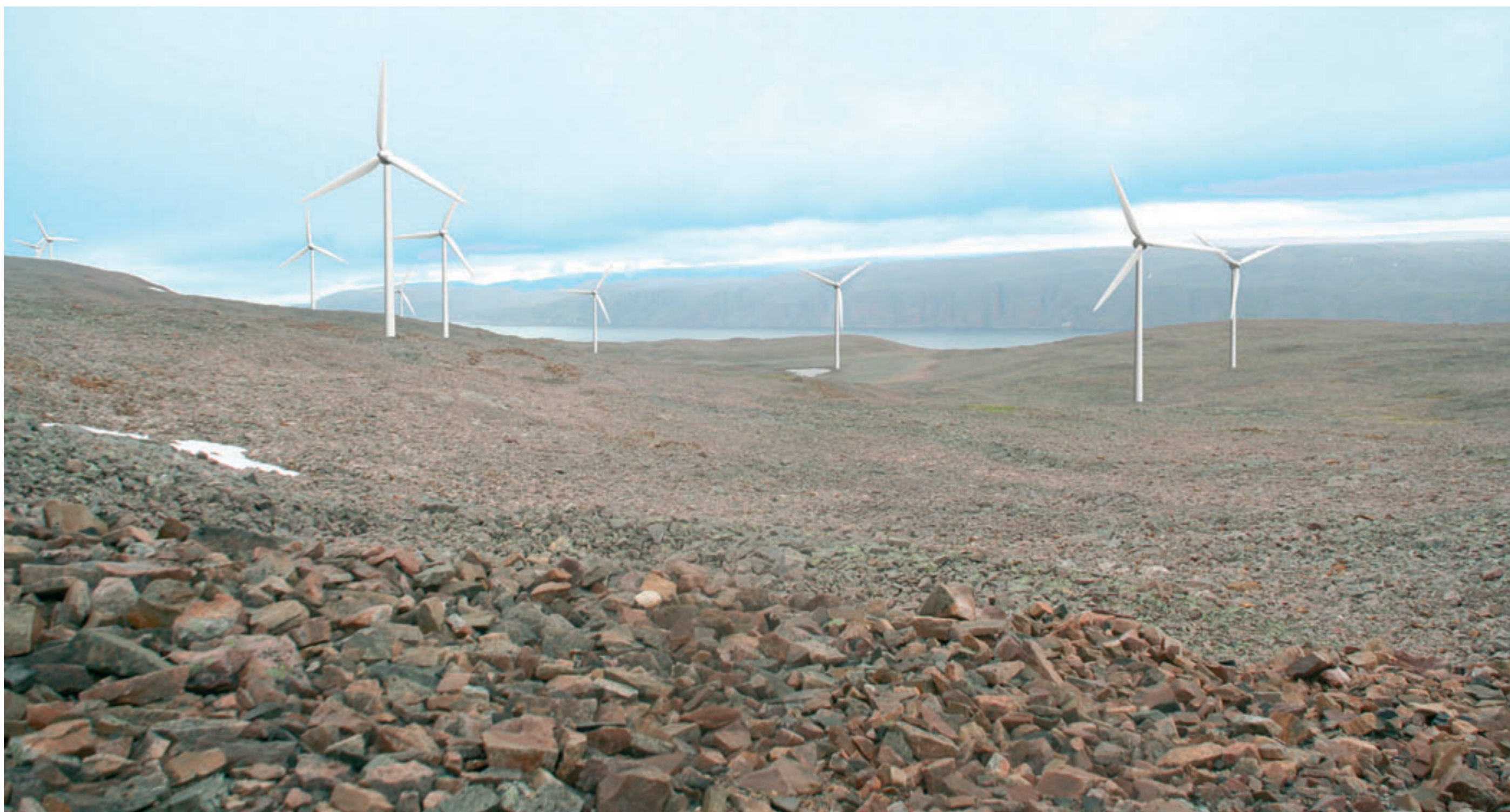
Sør for Hamnefjell telemast, 2 MW-vindturbin
