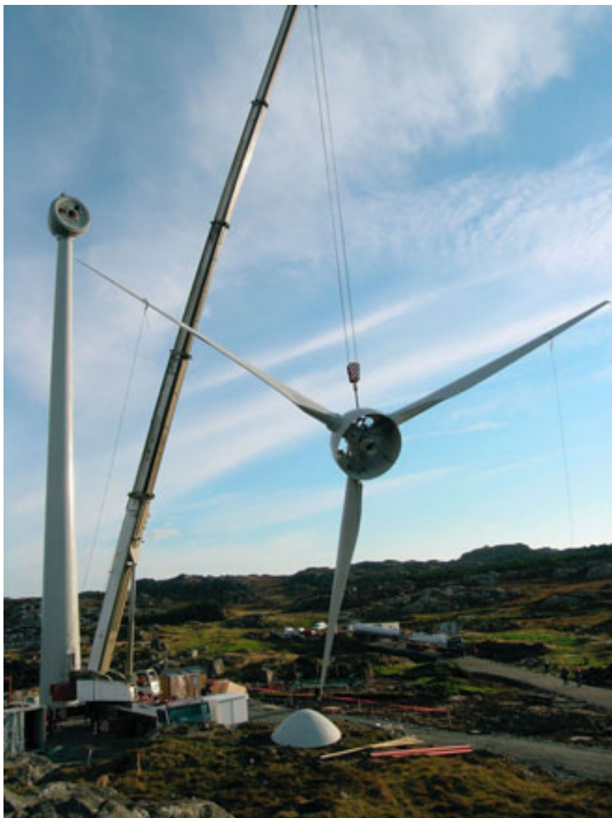
Fig. 6.4 Montering av turbin på Utsira.
