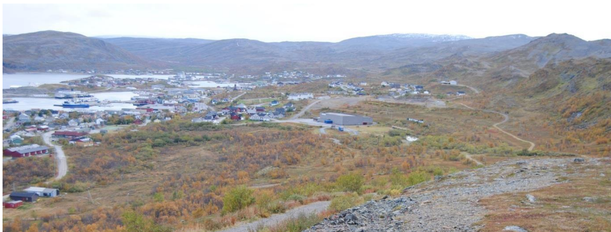
Figur 43: Nærfriluftsområdet over Båtsfjord. Lysløyppa ses slynge seg bortover under fjellkanten i høyre billedkant, og går også ned til garasjene nede i venstre billedkant. Byggene her skal fjernes og tomte brukes til servicebygget. Det store grå bygget sentralt i bildet er idrettshallen, utgangspunkt for idrettens sommer- og vinterbruk av de nærliggende traseene.
